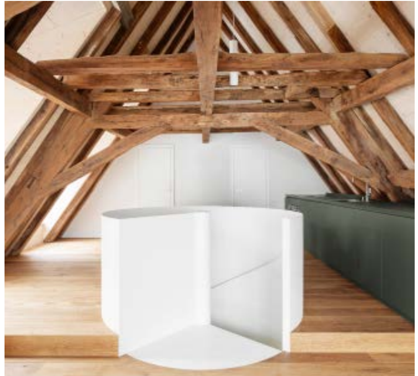
Im Dachgeschoss sind die freigelegten Deckenbalken und das sichtbare Sprengwerk das Highlight des Wohnraums.
